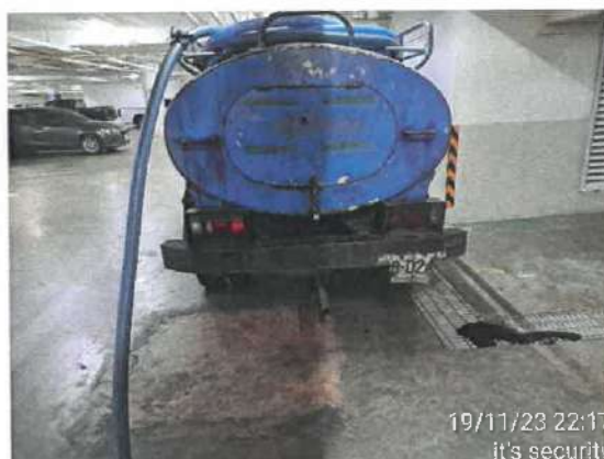
รูปที่ 9 ตักไขมันและสูบล้างถัง
