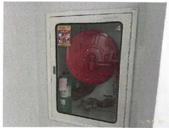
รูปที่ 32 ตู้เก็บสายฉีดน้ำดับเพลิงพร้อมอุปกรณ์ (FHC)
