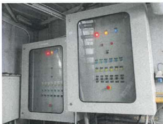
รูปที่ 7 แผงควบคุมระบบบำบัดน้ำเสีย
