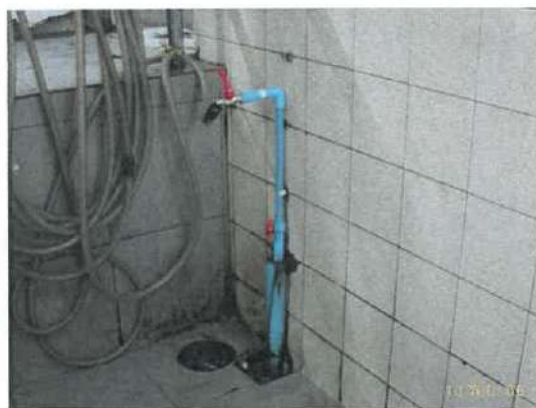
รูปที่ 22 ท่อรวบรวมน้ำจากการล้างห้องพักมูลฝอย
