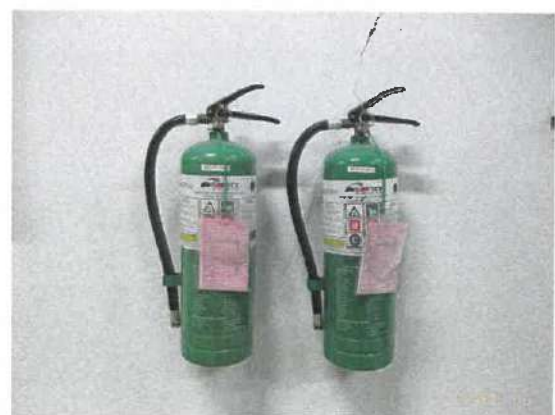
รูปที่ 33 ถังดับเพลิงเคมี ชนิด ABC ขนาด 10 ปอนด์
