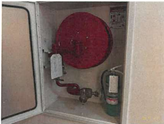
รูปที่ 32 ตู้เก็บสายฉีดน้ำดับเพลิงพร้อมอุปกรณ์ (FHC)
