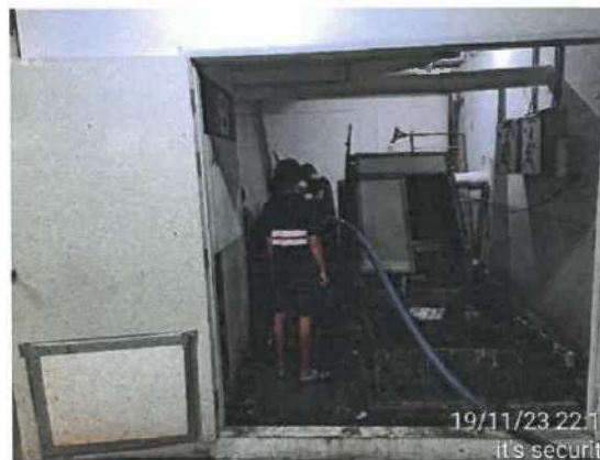
รูปที่ 9 ตักไขมันและสูบล้างถัง
