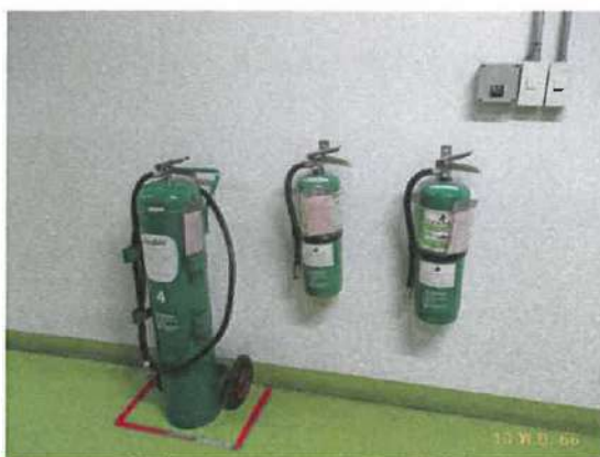
รูปที่ 33 ถังดับเพลิงเคมี ชนิด ABC ขนาด 10 ปอนด์
